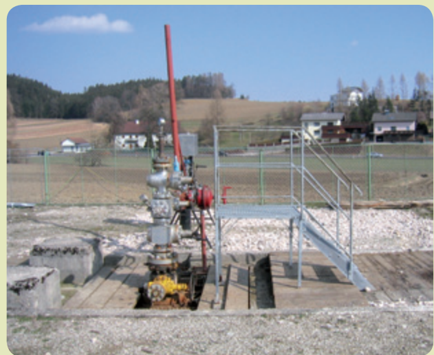
Abbildung 6: Ehemalige, noch nicht verfüllte Erdgasbohrung.
